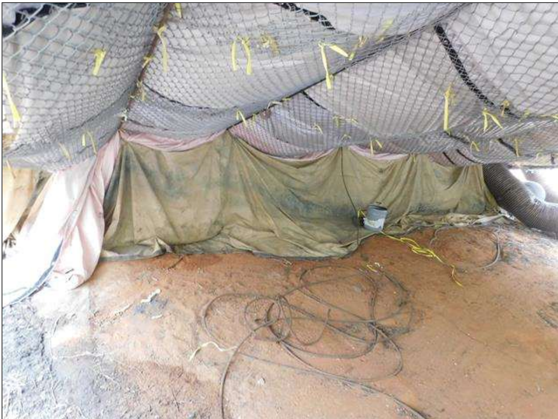
End Bent 1 (End Bent 2 similar)
